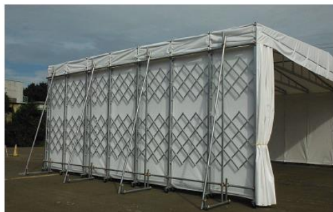
単管打ち込み固定
